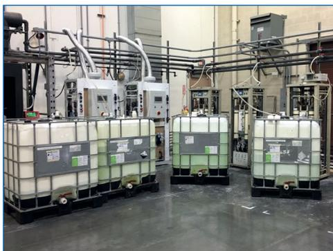
Шесть установок ECOCHLOR суммарной производительностью по хлору 7 кг/ч на химико-фармацевтическом предприятии Chemstar (США). Исключается необходимость в осушке, транспортировании и хранении хлора в баллонах.
